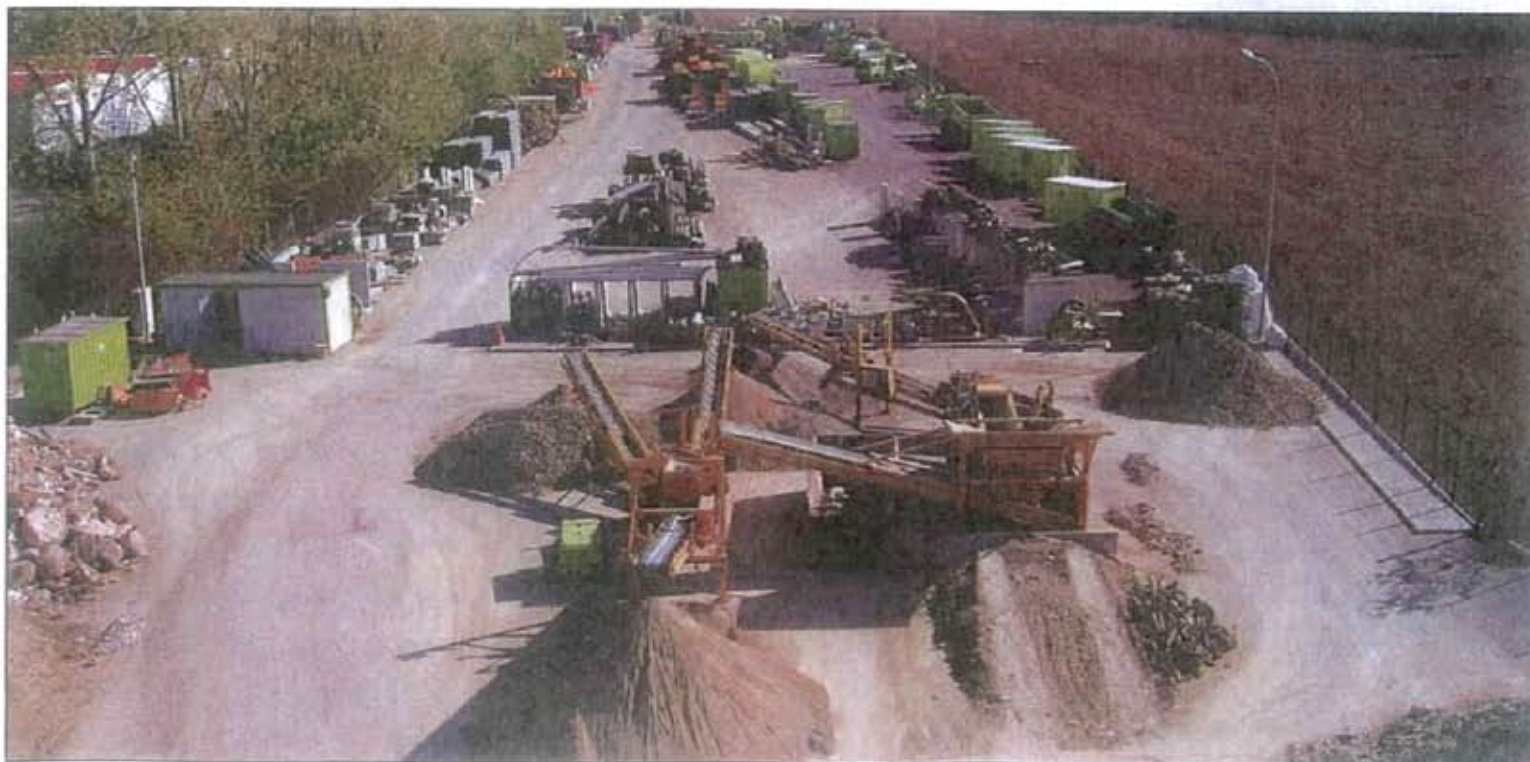
L'unité se compose déjà d'un RUBBLE MASTER RM60/4, d'un crible à deux étages CS-2 et d'un scalpeur VS-60 SFB entraînés par la génératrice du RM60/4.
